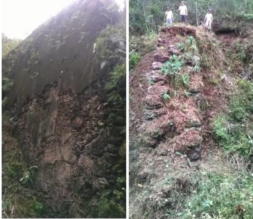
Figura 5.46 - Detalhe do barramento da Lagoa da Prata, com altura máxima de 9 metros. Revestimento com argamassa da parede interna do barramento (à esquerda) . Intercalação entre alvenaria de pedra-seca e argila - crescimento de vegetação – (à direita).
