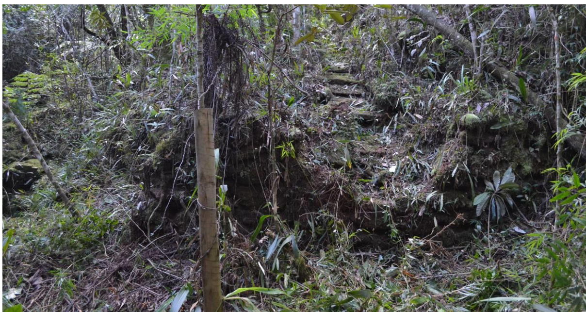
Figura 5.29 – Início aqueduto da Lagoa Azul. Nota-se a escada de direcionamento das águas para o canal de condução.
