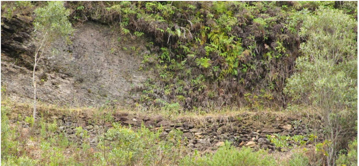
Figura 5.25 - Trecho onde a alvenaria de pedra-seca do Aqueduto do Xéu 2 se encontra do lado externo do canal.
