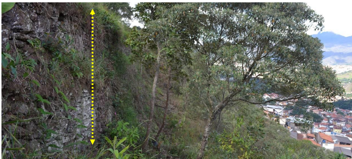
Figura 5.22 - Ponto onde a altura da estrutura de sustentação do aqueduto da Lagoa da Prata alcança quatro metros.
