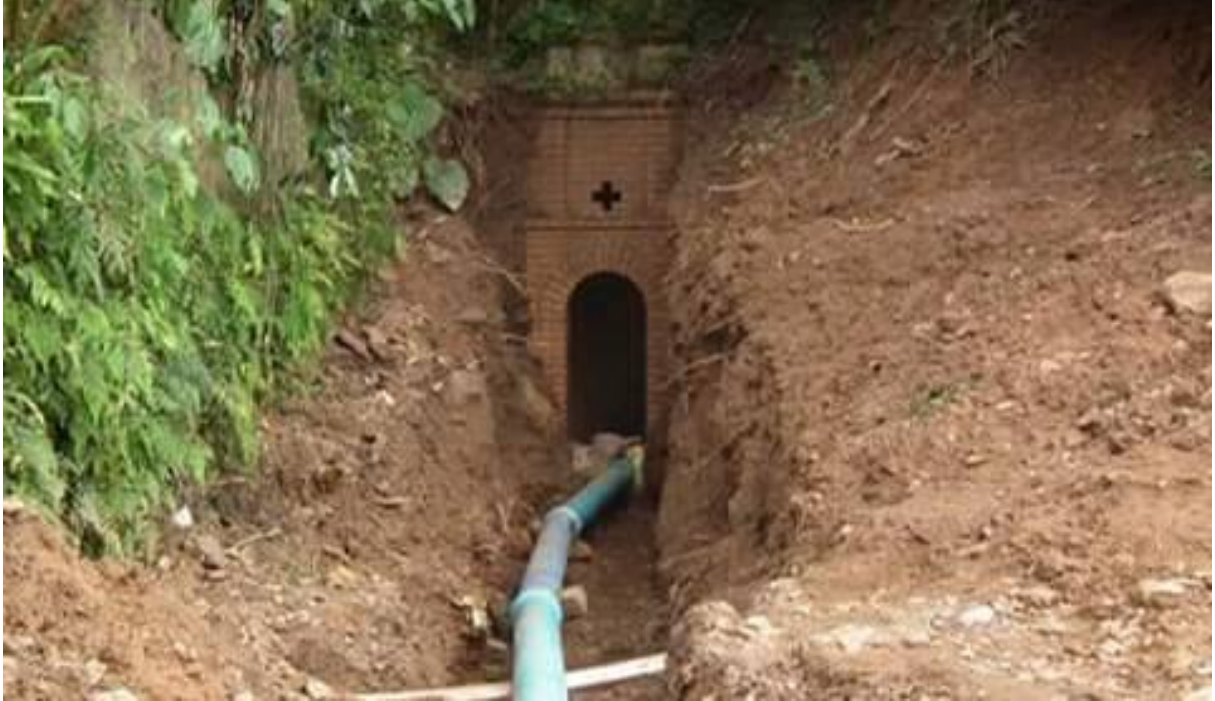
Figura 5.11 - Antiga galeria subterrânea para extração de ouro utilizada como fonte de abastecimento de água do SEMAE-OP (Reservatório 3).
