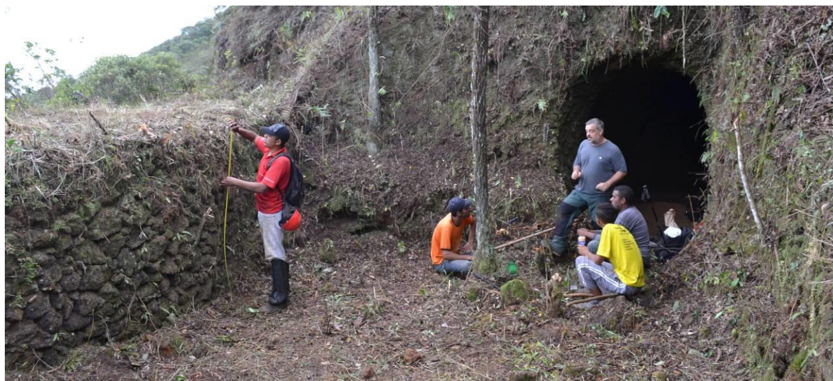
Figura 5.35 - Reservatório de acumulação de grandes dimensões localizado no final do aqueduto do Xéu-2. O ponto mais profundo do tanque possui 2 metros e a seção da galeria subterrânea na saída 2 x 2,5 metros (largura x altura). Na imagem, equipe de moradores do bairro que auxiliou na desobstrução da estrutura.
