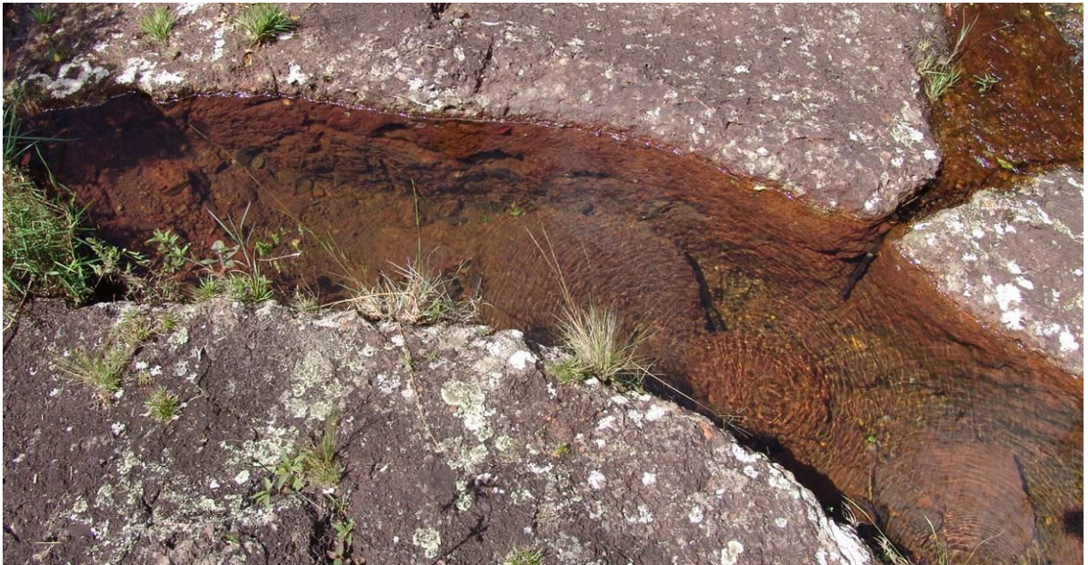
Figura 5.19 – Trecho do Aqueduto da Lagoa da Prata escavado na rocha (Fotógrafo: André Castanheira Maia 2005).
