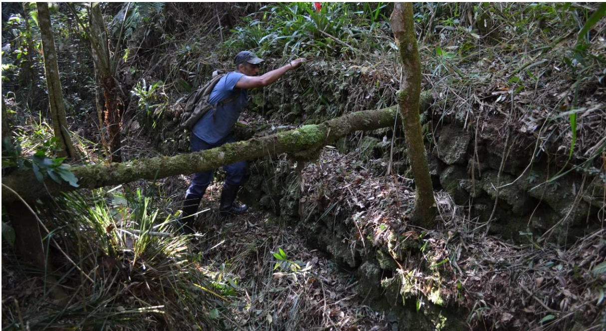
Figura 5.26 - Trecho onde a alvenaria de pedra-seca se encontra do lado interno do aqueduto da Lagoa Azul.
