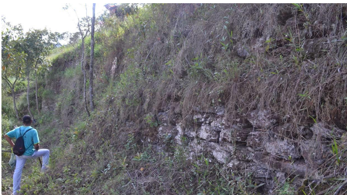
Figura 5.21 – Trecho do aqueduto da Lagoa da Prata onde o muro de pedra seca, que sustenta o aqueduto, possui grande altura.
