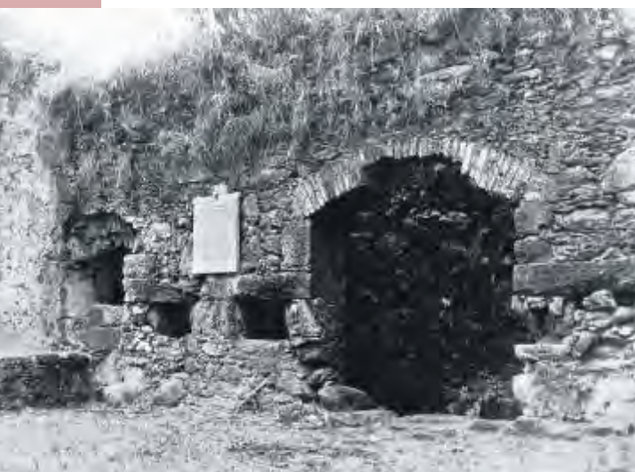
Ruínas da Fábrica Patriótica, (1811). Fachada, 1968.
