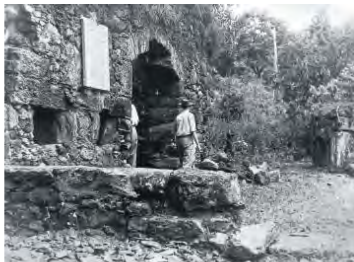
Ruínas da Fábrica Patriótica, (1811). Fachada, 1968.
