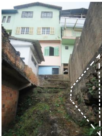
Vista 13: Delimitação por muros da Igreja, muros de pedra são acrescidos de alvenaria.
