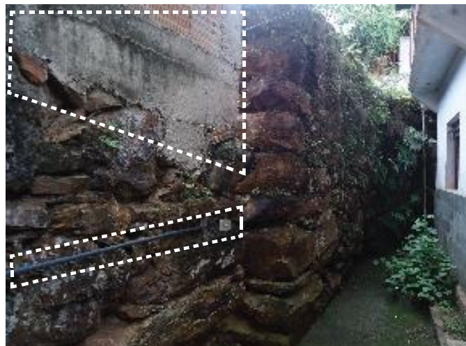
Vista 02: Muros de pedra com instalação elétrica e estrutura mista de alvenaria acrescida.
