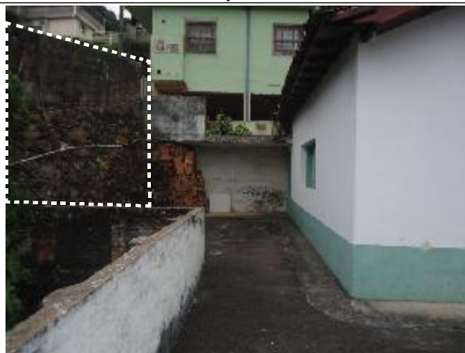
Vista 06: Vista dos fundos da capela. Observa-se o muro de pedra com acréscimo de alvenaria.
