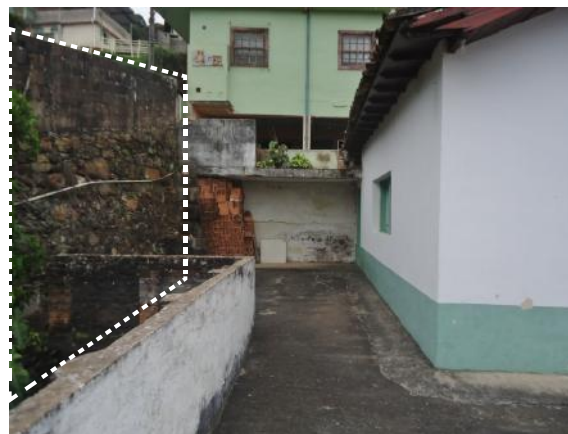
Vista 06: Vista dos fundos da capela. Observa-se o muro de pedra com acréscimo de alvenaria.
