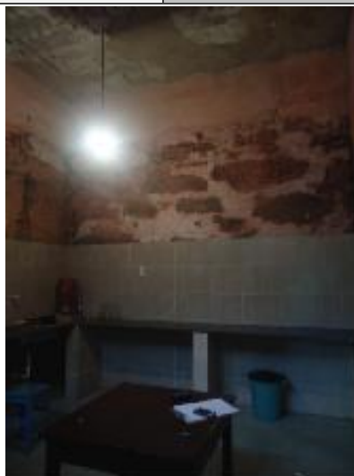
Vista 18: Muro de pedra revestido.
