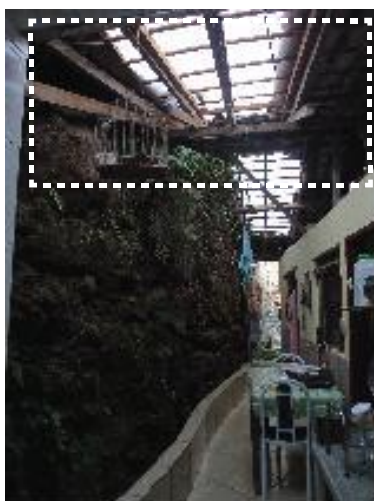
Vista 05: Muro de pedra incorporado a edificação adjacente como vedação e suporte a cobertura.
