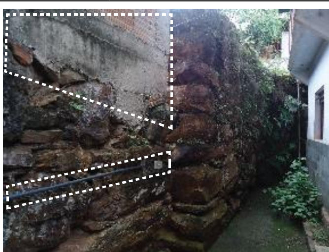
Vista 02: Muros de pedra com instalação elétrica E estrutura mista de alvenaria acrescida.
