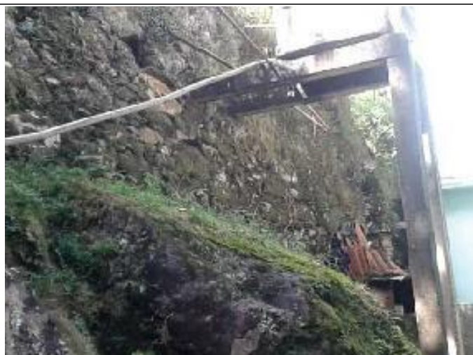
Vista 14: O muro é utilizado como delimitador do lote e apoio para a estrutura da caixa d'água.
