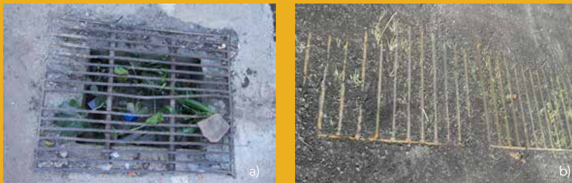
Figura 45 - Equipamentos de drenagem obstruídos no bairro São Cristóvão. Autoria: Bárbara Oliveira. Data: Desconhecida
