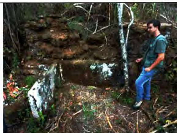
Figura 34, 35 e 36 – A foto ao lado e as duas que aparecem no topo da próxima página foram tiradas em 2014, e mostram a degradação e abandono do Chafariz, que já aparece sem a carranca e o reservatório d'água. Da construção original restavam apenas a parede de estruturação e duas lajes de pedra do tanque retangular. Bernardo Andrade, 2014.
