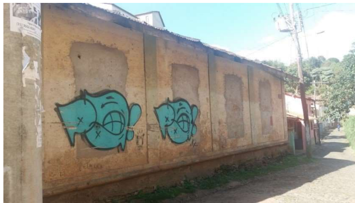
Figura 29- Antigas janelas concretadas
