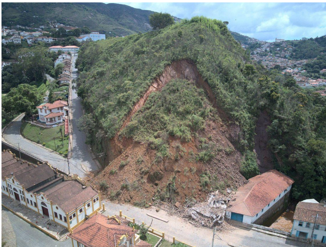
Figura 5 — Escorregamento em área urbana de Ouro Preto: a água como gatilho de processos que revelam fragilidades históricas do território. Fonte: material apresentado pelo autor no 7º Colóquio Ibero-Americano Paisagem Cultural, Patrimônio e Projeto, 2026.
